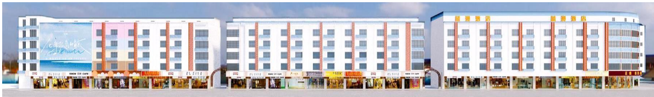
南侧建筑立面改造(新港街道)
