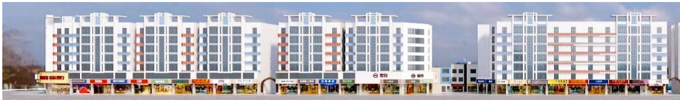
南侧建筑立面改造(新港街道)
