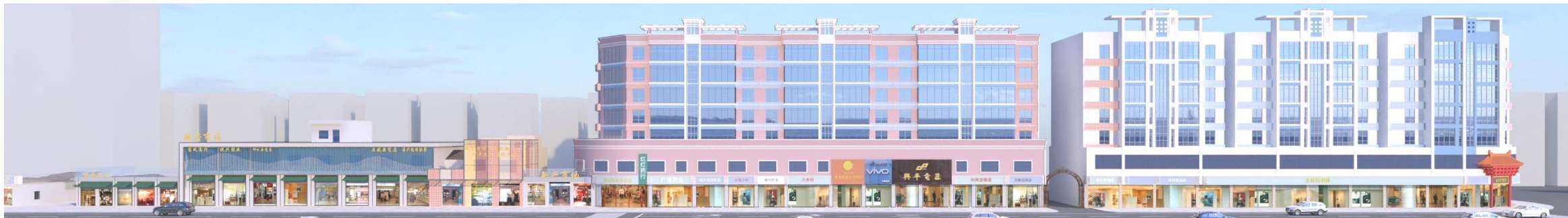
城南路至红海西路沿线建筑立面改造
