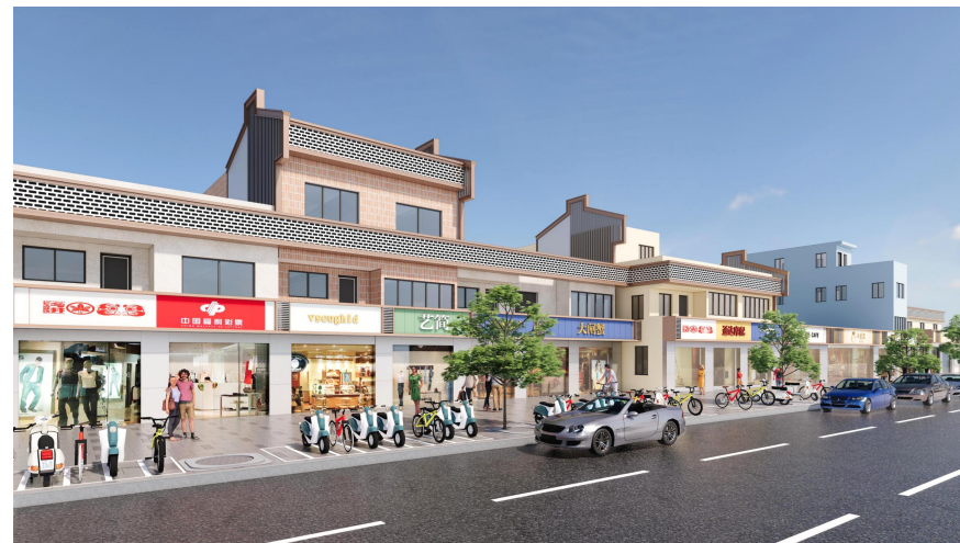
南侧建筑立面改造(新港街道)
