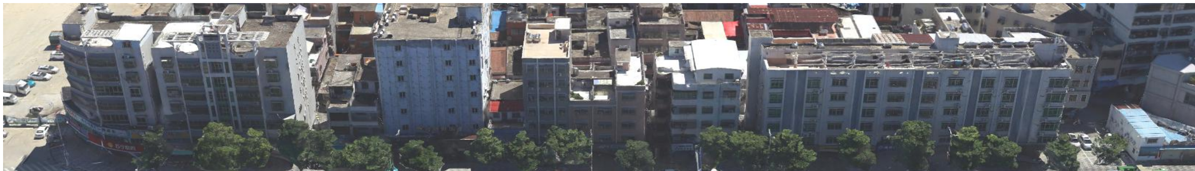
城南路至红海西路沿线建筑立面现状
