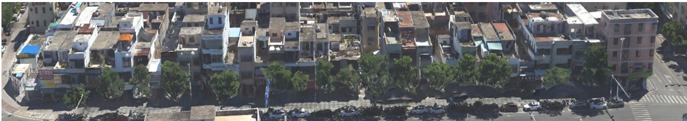
城南路至红海西路沿线建筑立面现状
